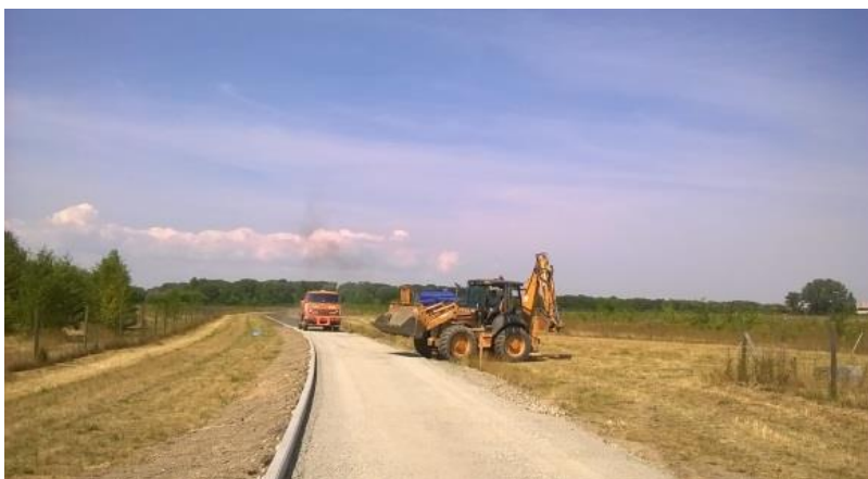
Obrázek 19: Výstavba cyklostezky včetně lávky přes železnici, jaro 2018 [8]
