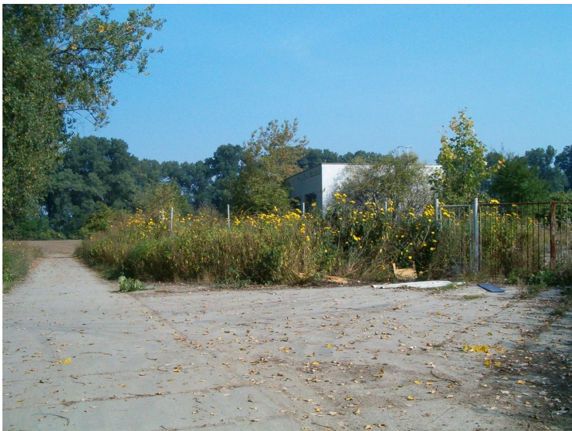
Čerpací stanice užitkové vody na břehu Moravy
