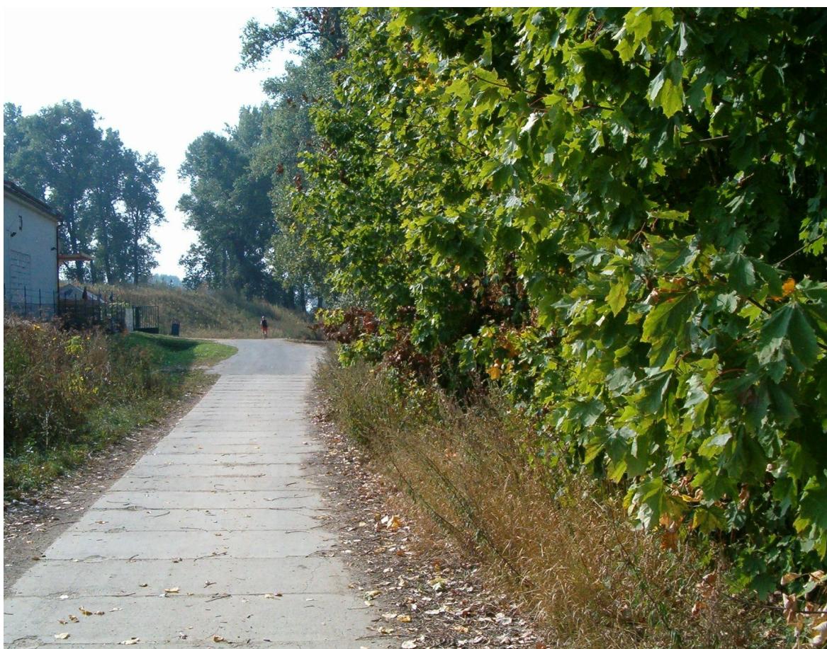
Panelová cesta obsluhující objekty na ostrově
