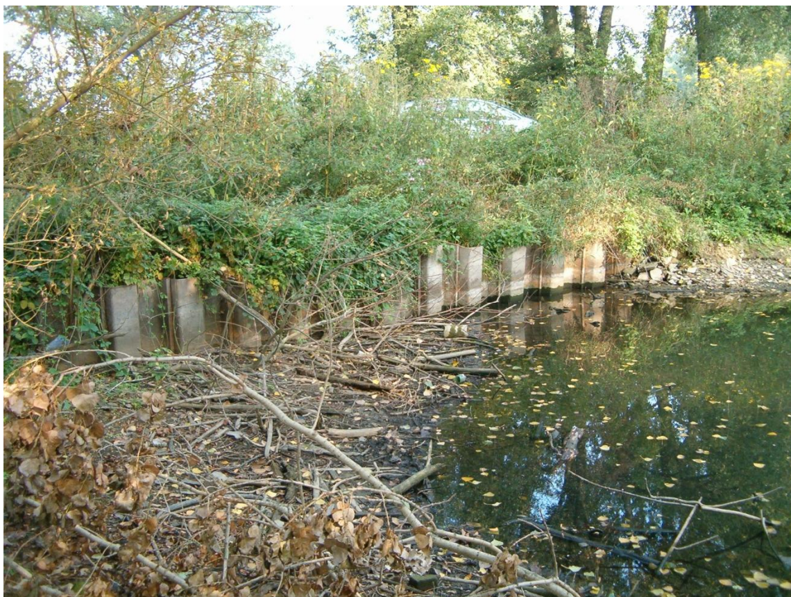
Ocelové štětovnice uzavírají výtokovou část ramene Moravy
